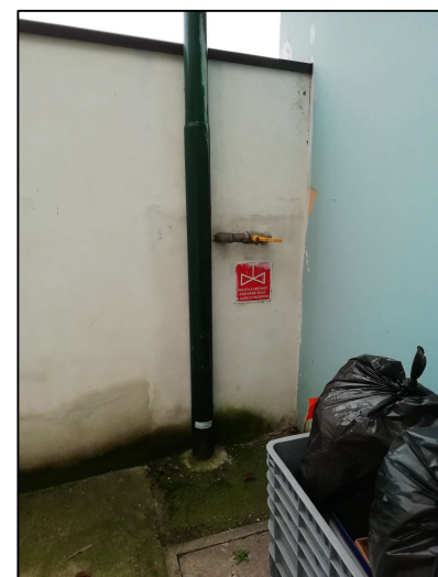
VALVOLA DI INTERCETTAZIONE GAS METANO
