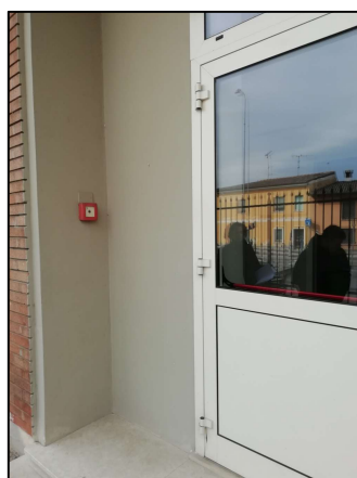
INTERRUTTORE ELETTRICO GENERALE PLESSO SECONDARIA PRIMO GRADO
